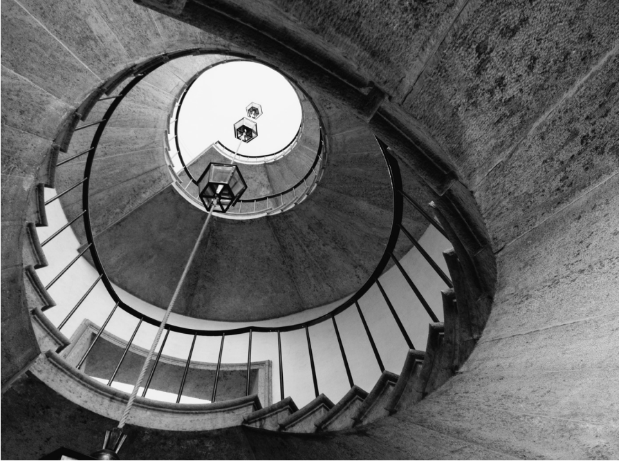
Wilhelmstraße 9, Altbau, Treppenhaus.
